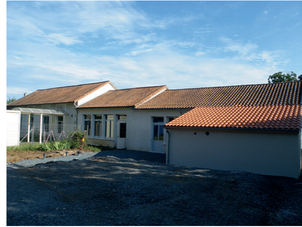
Construction d'une réserve pour le restaurant scolaire
