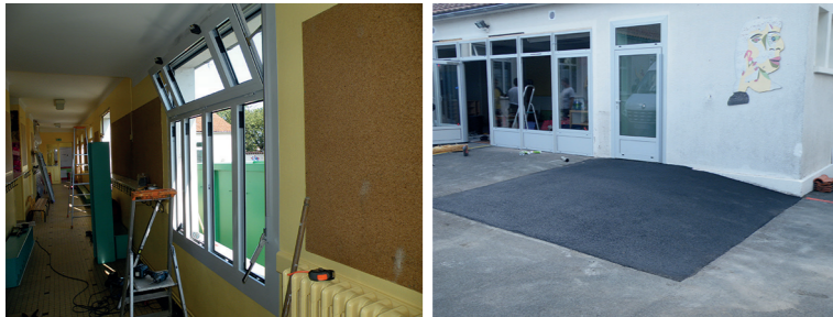
Remplacement des menuiseries extérieures
